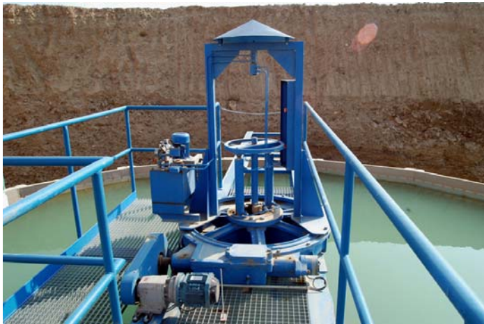
Cabeza de mando con elevador de palas hidráulico
